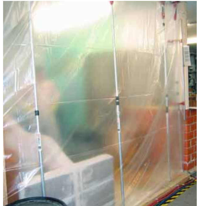
Figura 4: i teli di plastica formano una barriera igienica.
