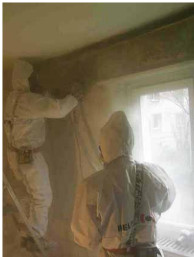
Figura 3: lavori di risanamento con intensa emissione di polvere ed elevata esposizione.
