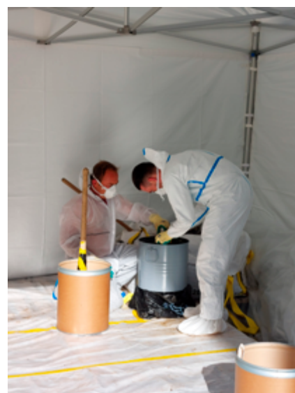
Figure 21 Conditionnement de terre fortement contaminée au radium-226 en vue de son élimination au dépôt intermédiaire fédéral
