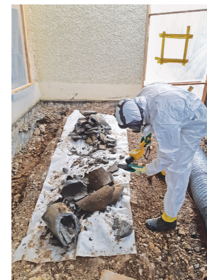
Figure 17 : Chantier de décontamination d'une parcelle avec des pollutions mixtes
