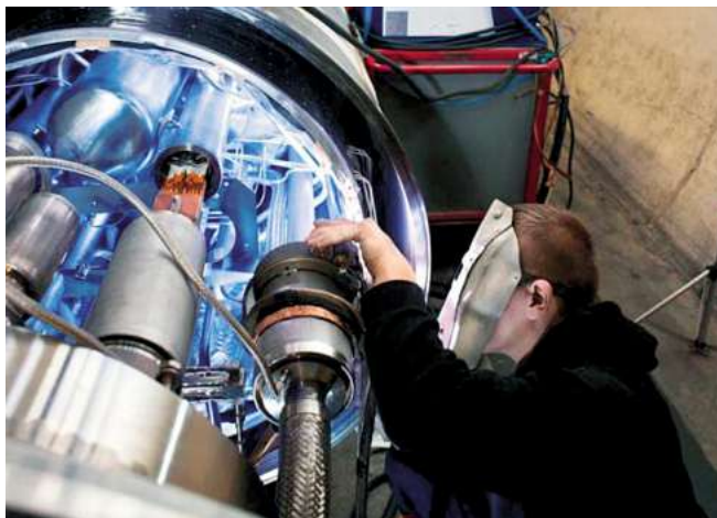
Fig. 5 : Mise à niveau des systèmes d'interconnexion du système cryogénique : l'une des grandes tâches du long arrêt technique 2013/2014 au CERN
