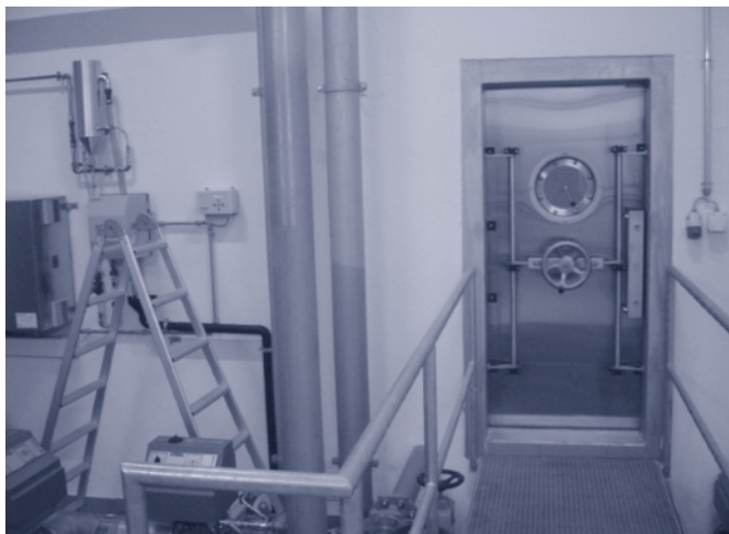
Fig. 14 : Selon les prescriptions d'hygiène actuelles, les réservoirs d'eau doivent être fermés et ne sont accessibles qu'à des fins de nettoyage
