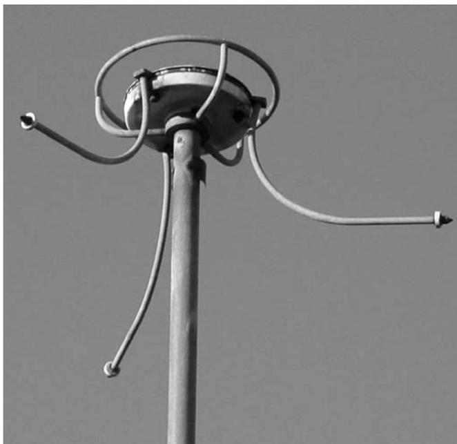
**Fig. 8: Paratonnerre contenant du radium.**
