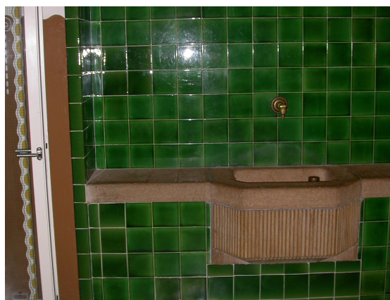
Fig. 6: Carreau de céramique vert de 1910 contenant de l'uranium
