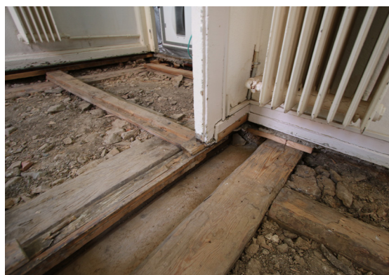
Fig. 19: Remblai isolant composé de scories
