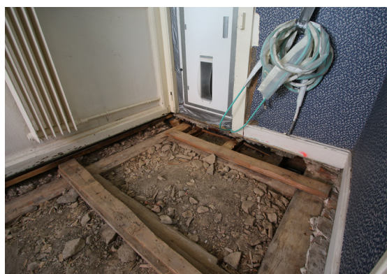
Fig. 20: Remblai isolant composé de scories
