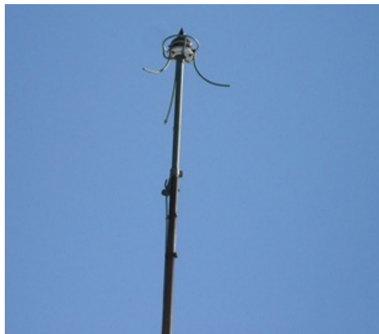
Fig. 9: Paratonnerre avec Ra-226
