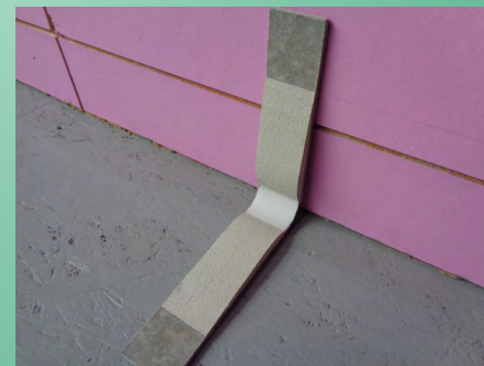
Pose d'une membrane pare-radon à la jonction sol-mur
