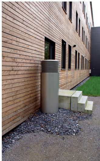
Prise d'air pour la ventilation contrôlée des locaux d'habitation (au moins 80 cm au-dessus du sol)
