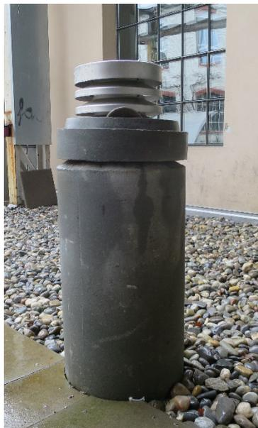
*Illustration 3 : Appareil de ventilation dans le mur avec récupération de chaleur et collecteur d'air frais*
