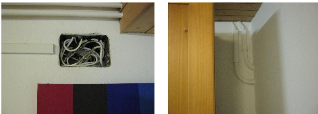
*Illustration 1 : Passages de conduite à travers le mur extérieur*
