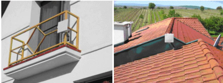
**Figure 7** Installations d'émission/réception WiMAX fixées aux façades ou sur les toits. Source :<sup>18</sup>
