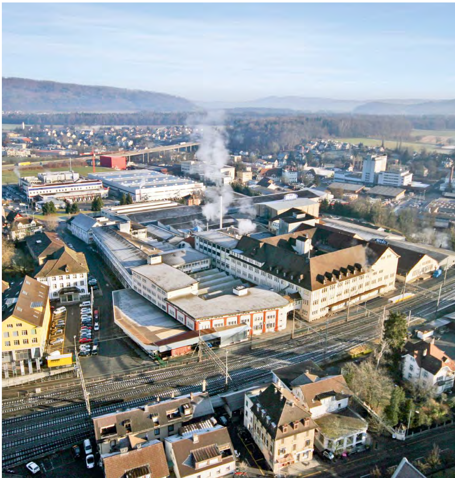
Le site de la fabrique de conserves Hero, riche en traditions, va se transformer en un quartier durable avec de nouveaux logements et places de travail. Les travaux de construction sont en cours. (Photo: Losinger Marazzi AG)
