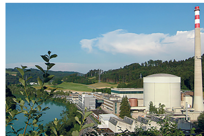
Abb. 19: Das Szenario Notfall im KKW Mühleberg als Rahmen für die Gesamtnotfallübung 2017
