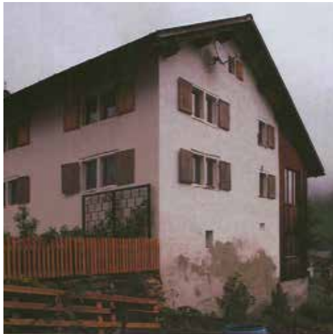
Abbildung 6.31 (links): Der historische Gebäudeteil ist über 400 Jahre alt.
