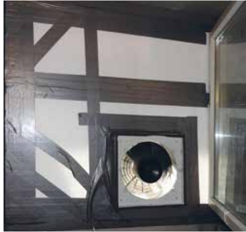
Abbildung 6.8 (links): Erste Entlüftungsversuche wurden über das Kellerfenster durchgeführt.
