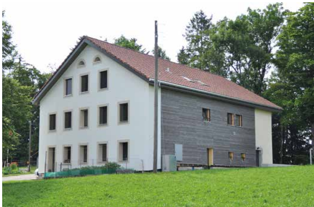
Abbildung 6.91: Das Haus wurde nach Minergie-Standard komplett erneuert.
