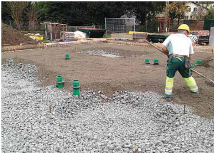
Abbildung 6.98: Eine Splitlage unter der Bodenplatte dient als Ausgleichsschicht.
