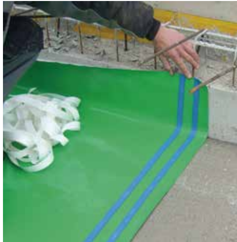
Abbildung 4.11 (links): Radonfolie im Sockelbereich hochziehen, um eine Überlappung mit der Folie an der Wand zu ermöglichen (Quelle: Ampack).
