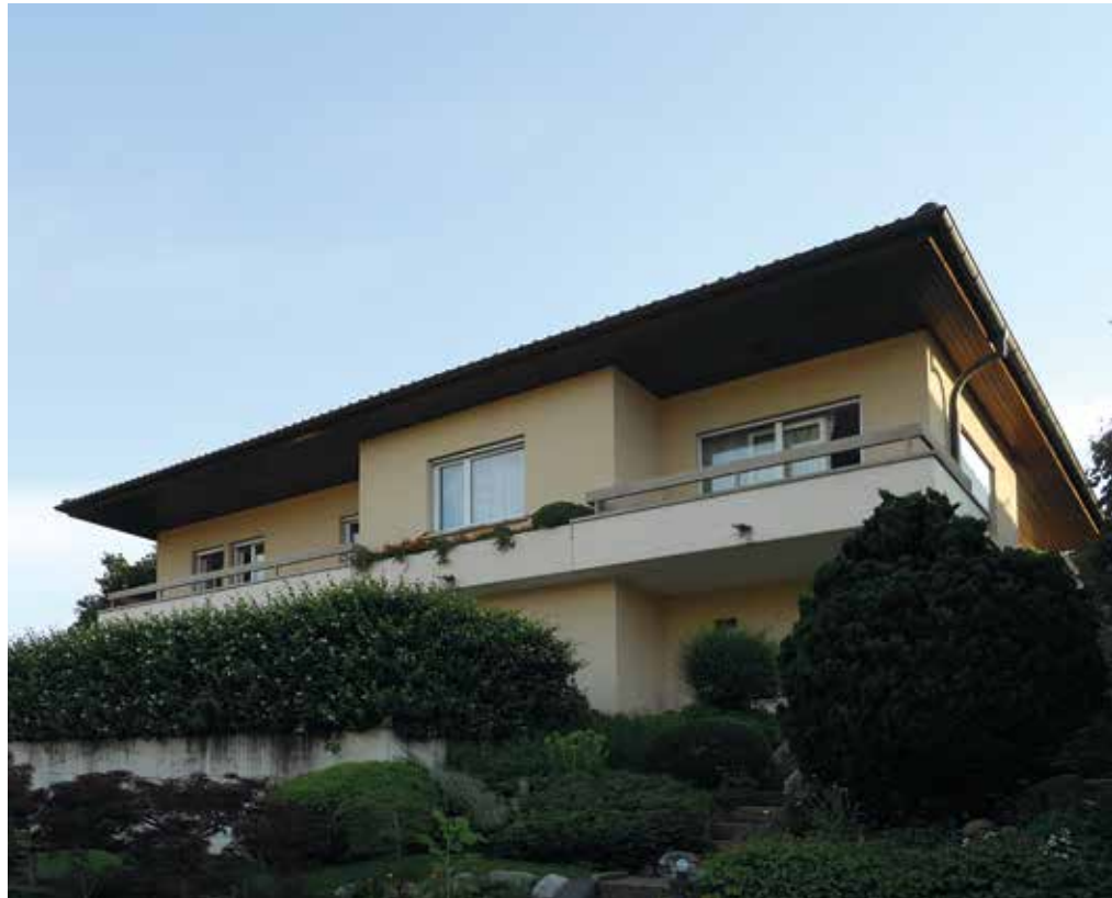
Abbildung 6.12: Unter dem Einfamilienhaus befindet sich ein Kriechkeller.
