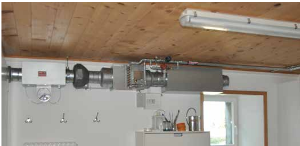
Abbildung 6.41: Als Sanierungsmaßnahme folgte der Einbau einer Überdruck-Lüftungsanlage in der Waschküche.
