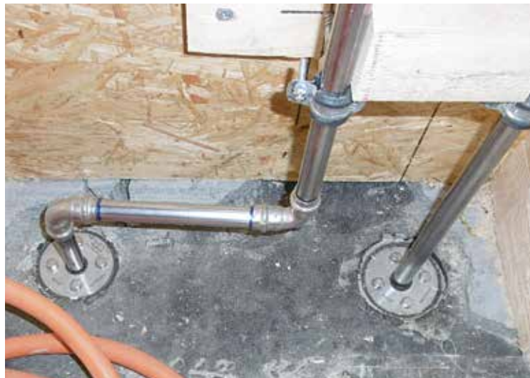
Abbildung 6.101: Radondicht durch die Betondecke.
