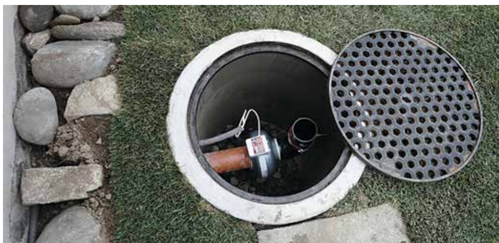
Abbildung 6.5: Die Mündung des Radonbrunnens befindet sich neben dem Haus.
