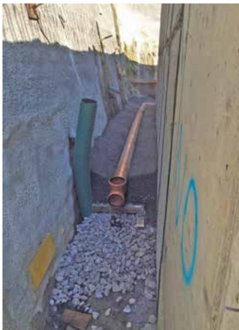
Abbildung 6.86 (links): Detail der Radondrainage.
