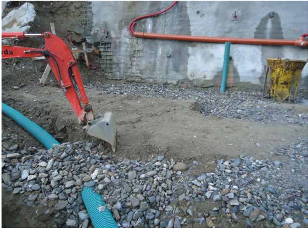
Abbildung 6.85: Einbau der Radondrainage.
