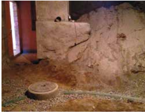
Abbildung 6.26 (links): Bodenschacht und Drainagerohr: Im Hintergrund das aus dem Untergrund ragende Gestein.
