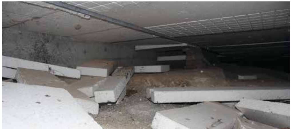
Abbildung 6.63: Unter dem Kindergartengebäude (oben) befindet sich ein Hohlraum (Kriechkeller).
