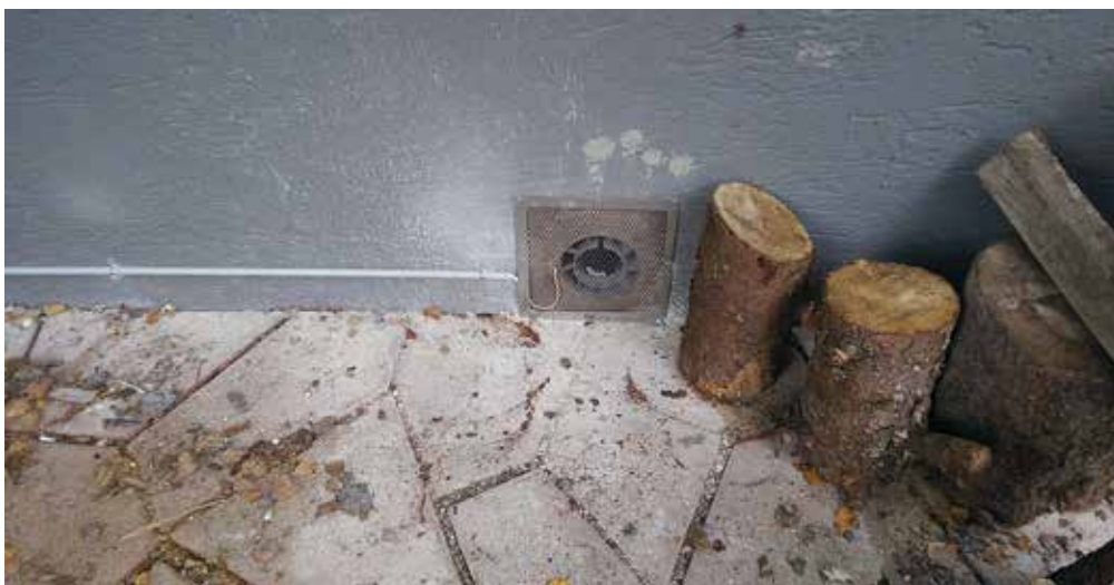
Abbildung 6.56: Die endgültige Montage des Radonbrunnens.
