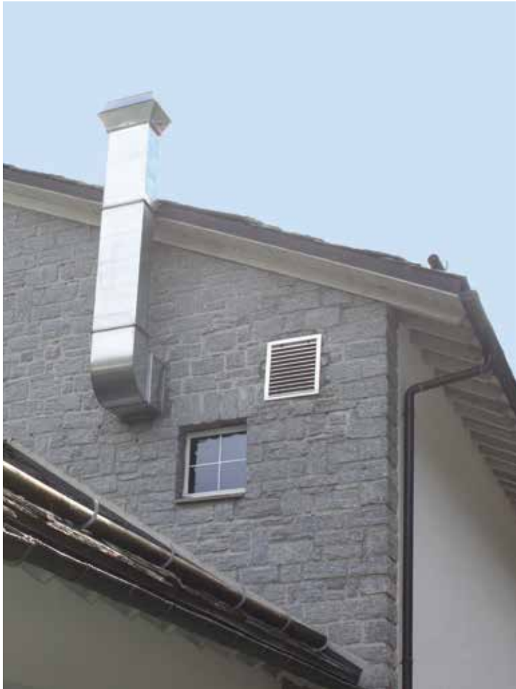
Abbildung 6.59: Die konstruktive Verlängerung der Fortluftleitung minimiert den Kurzschluss zwischen den Lüftungsströmen.
