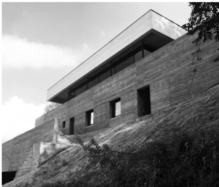
Abbildung 6.84: Das Erdgeschoss des Einfamilienhauses ist überwiegend von Erdreich umgeben.
