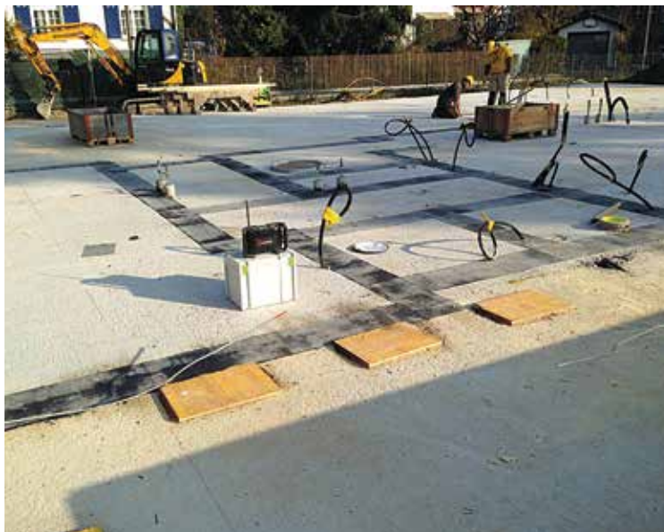
Abbildung 6.99: Feuchte- und Radonschutzmassnahmen auf der Kellerdecke.
