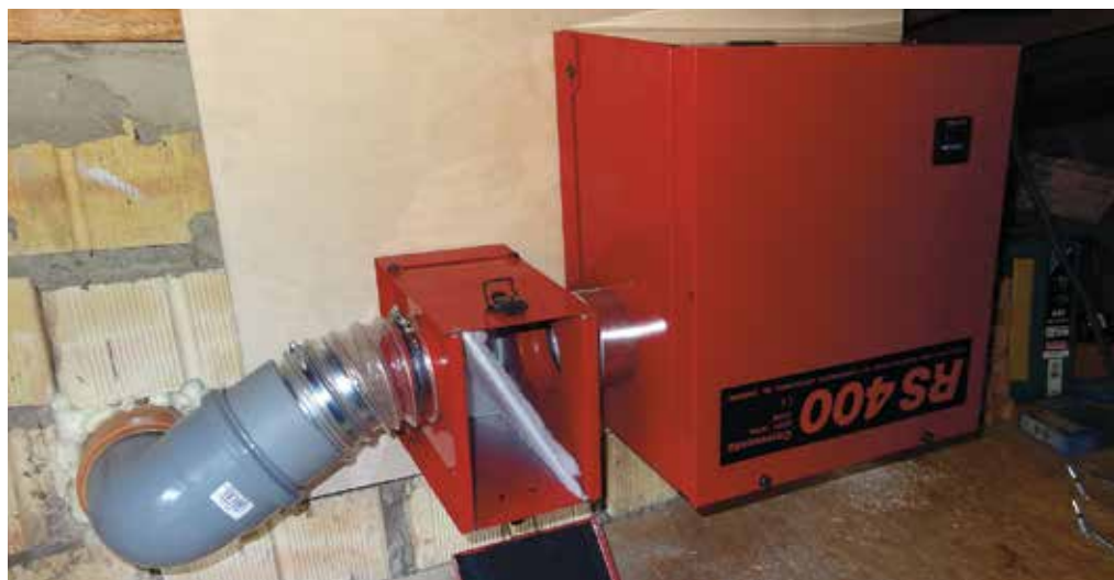
Abbildung 6.23: Aus Platzgründen und um Geräuschmissionen im Schlafbereich zu verhindern, wurde das Lüftungsrohr ausserhalb des Gebäudes montiert.
