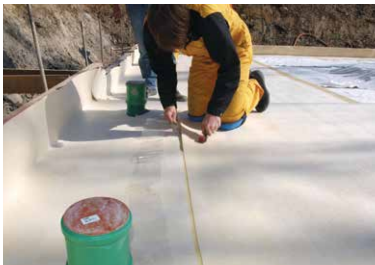
Abbildung 4.10 (unten rechts): Aussenseitige Abdichtung der Wände im Untergeschoss mit Dichtungsbahnen (Quelle: Sika).
