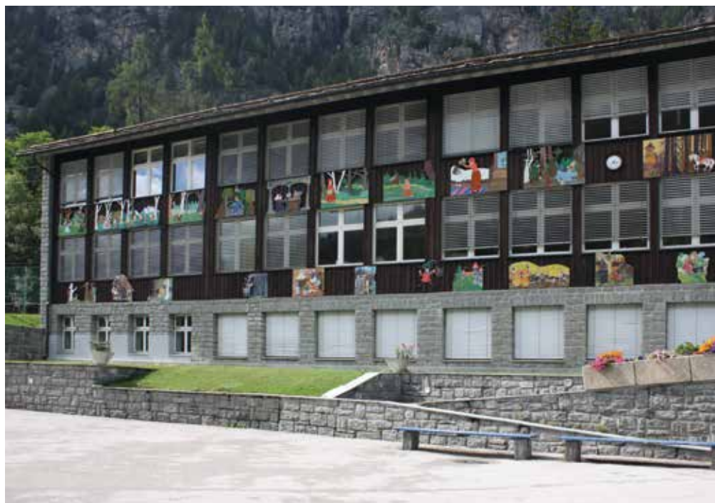
Abbildung 6.58: Primarschulhaus im Kanton Wallis, Ansicht Südflügel.
