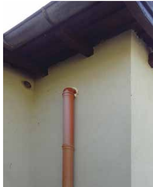
Abbildung 6.23: Aus Platzgründen und um Geräuschmissionen im Schlafbereich zu verhindern, wurde das Lüftungsrohr ausserhalb des Gebäudes montiert.
