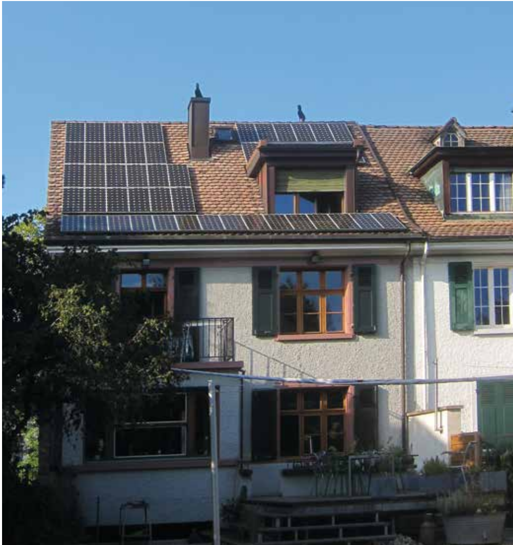
Abbildung 6.77: Beim Gebäude aus den 1920er-Jahren führte der Einbau von dichten Wärmeschutzfenstern zu einer Verschlechterung der Radonsituation.
