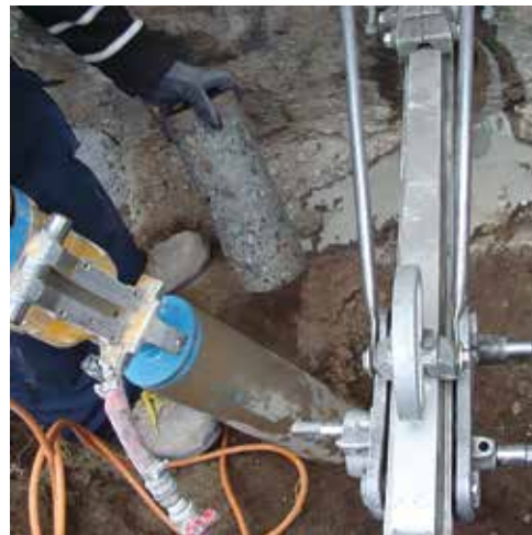
Abbildung 6.4: Für den externen Radonbrunnen wurde eine Bohrung neben und unter dem Haus durchgeführt.
