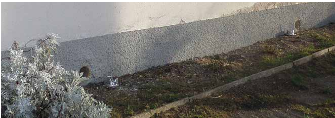
Abbildung 6.16 (oben): Am Haus wurden bereits früher erste Radonschutzmassnahmen getroffen.
