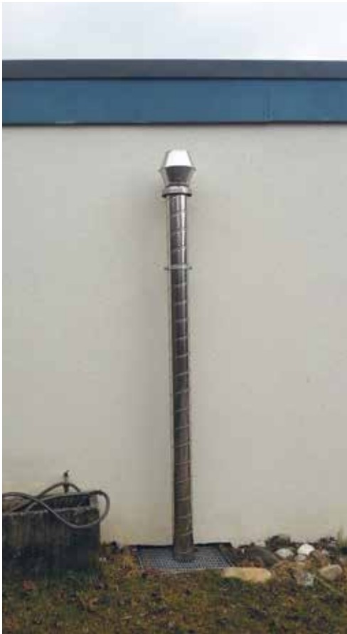
Abbildung 6.65: Im Kriechkeller wurde eine Unterbodenabsaugung installiert.
