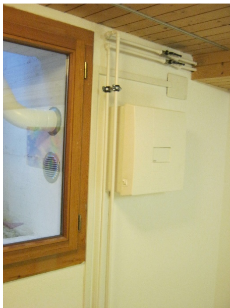
Abb. 3 Wandlüftungsgerät mit Wärmetauscher und Ansaugstutzen Frischluft
