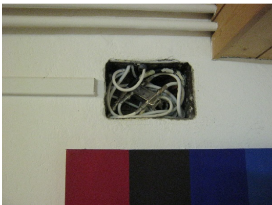
Abb. 1 Leitungsdurchführungen Aussenwände
