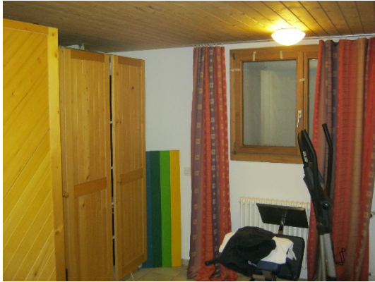
Abb. 2 Fenster mit Lichtschacht
