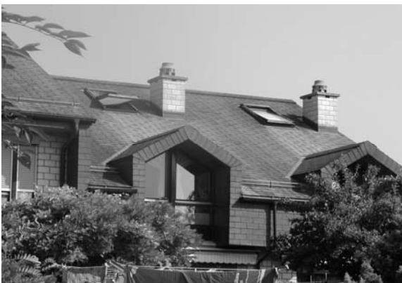
Dachschiefer aus Asbestzement, Foto IST
