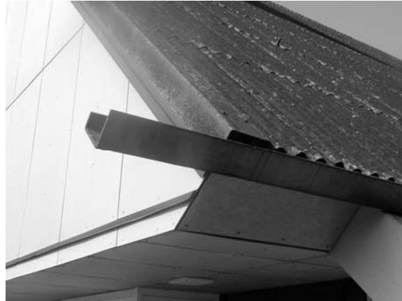
Asbestzement-Wellplatten, Foto IST
