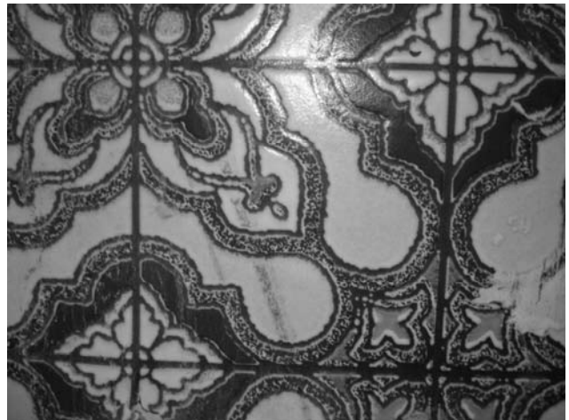
Dreischichtiger Bodenbelag mit Asbestpappe, Foto: Carbotech AG
